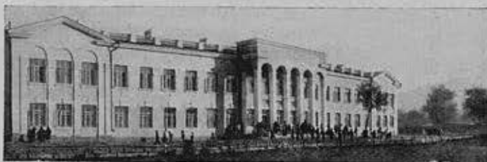
Школа на ул. Куйбышева Арх. Покровская
