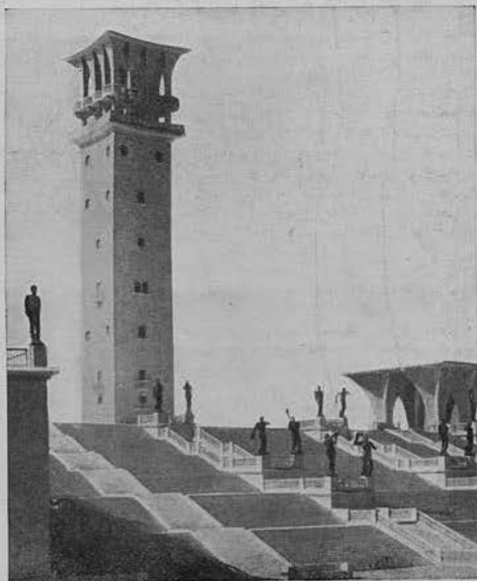
Главный вход Фрагмент
