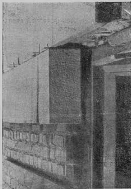
Установка белых искусственных облицовочных плит при отделке фасадов жилых домов
