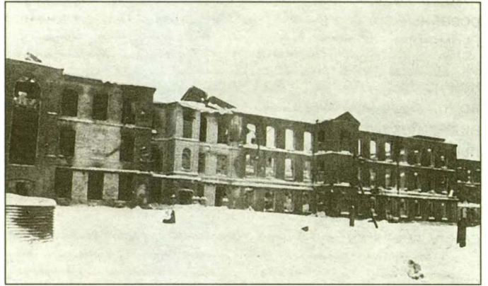
Сожженный корпус прядильной фабрики. Яхрома. 1942 г. ГИМ
