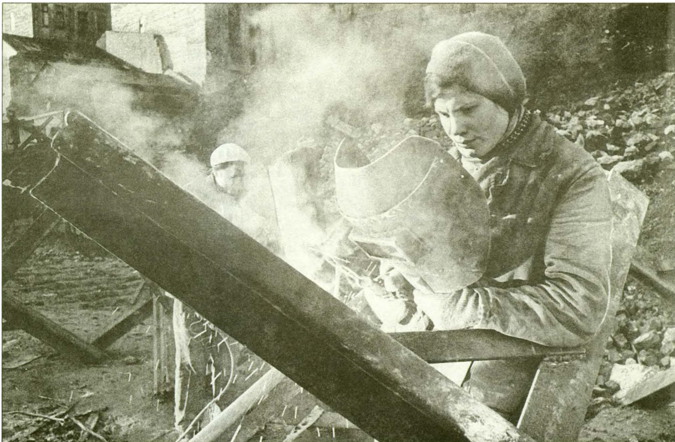
Сварка ежей для противотанковых заграждений. 1941 г. РГАКФД
