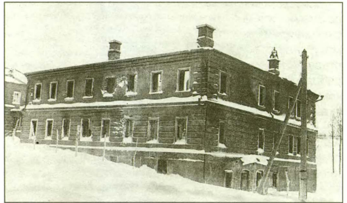
Разрушенный дом учителей. Яхрома. 1942 г. ГИМ
